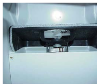
Evaporator Fan Motor Assembly
